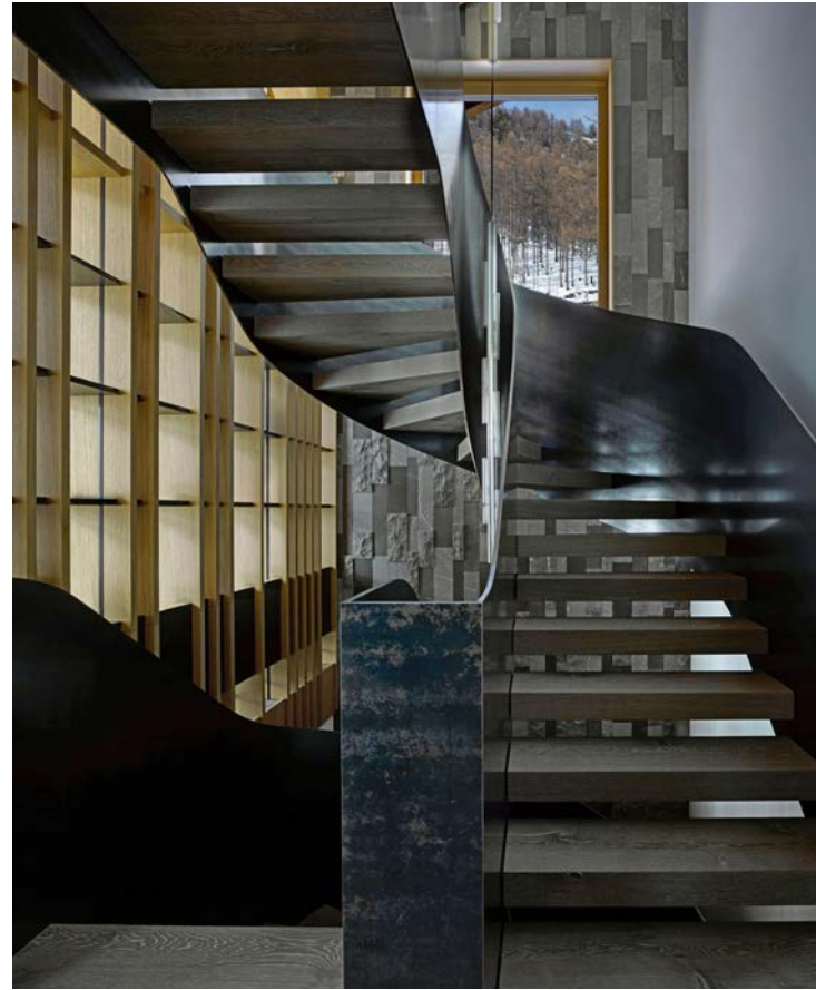
Oben: Die spektakuläre dreiteilige Treppe ist aus Schwarzstahl gefertigt.
